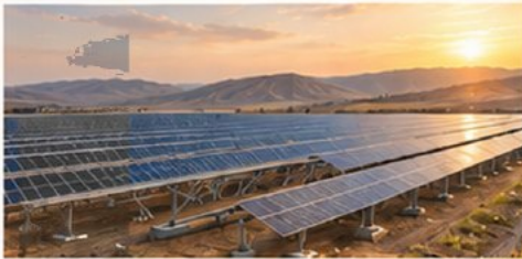
ETİ KROM 44 MW GES ELAZIĞ
